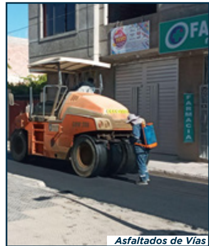
Asfaltados de Vías
